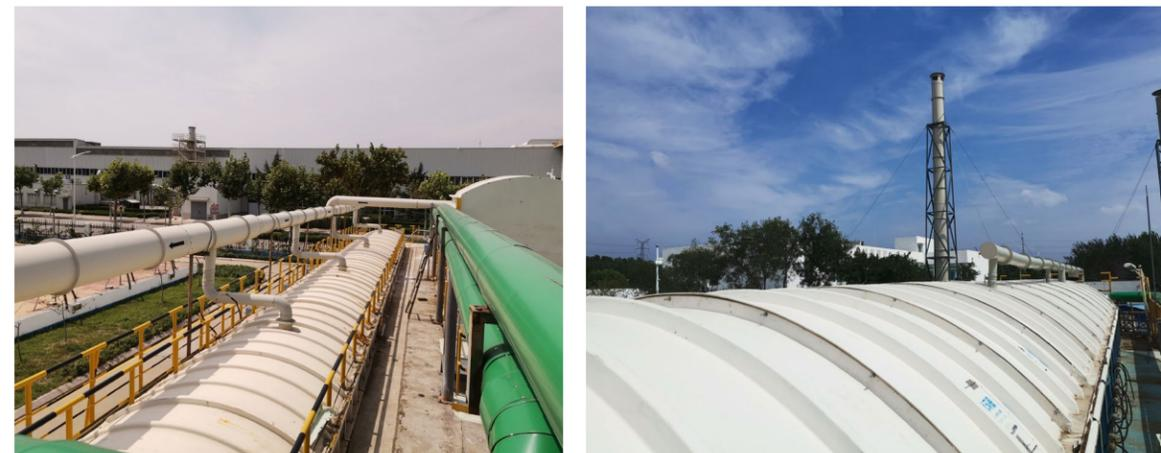
对高新区污水站恶臭气体进行收集和治理，确保污水站无恶臭气体逸散
