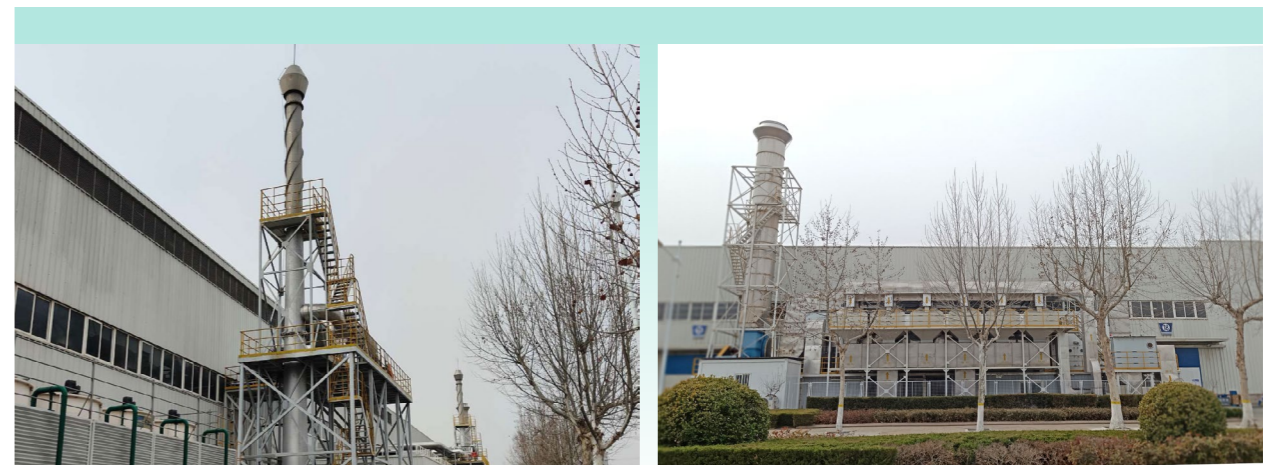
完成试车废气治理设施的建设及投用
